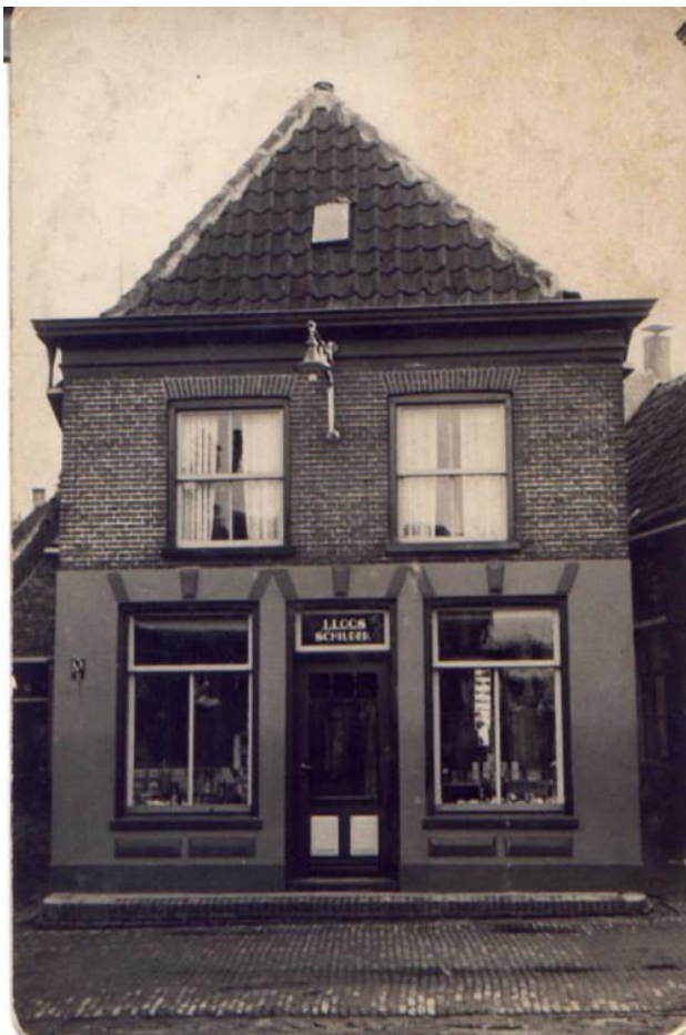
Pand Kerkstraat 6, tegenover de Schoolstraat, waarin woonhuis annex schildersbedrijf.
